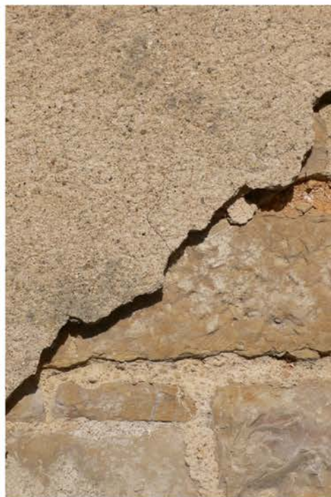
Maçonnerie de moellons jointés et enduits
