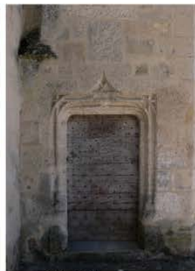
Détail d'une porte
