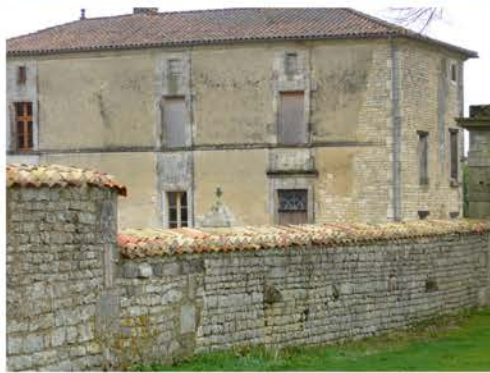
Moellons calcaires équarris et assisés
