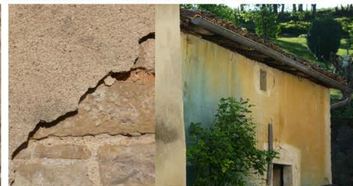
Maçonnerie jointée puis enduite
