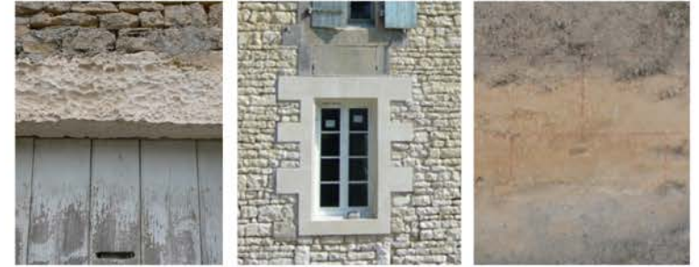
Linteau salpêtré - Restauration d'un encadrement de fenêtre - Joints en trompe-l'oeil sur un enduit ancien.
