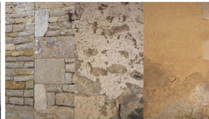
Détail de maçonnerie
