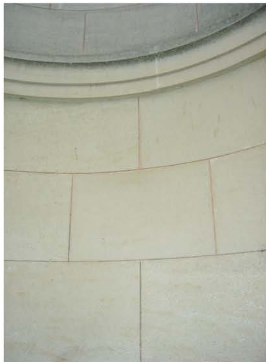
Mur concave de pierre de taille, avec couleur des joints renforcée par un liant contenant de la poudre de tuiles
