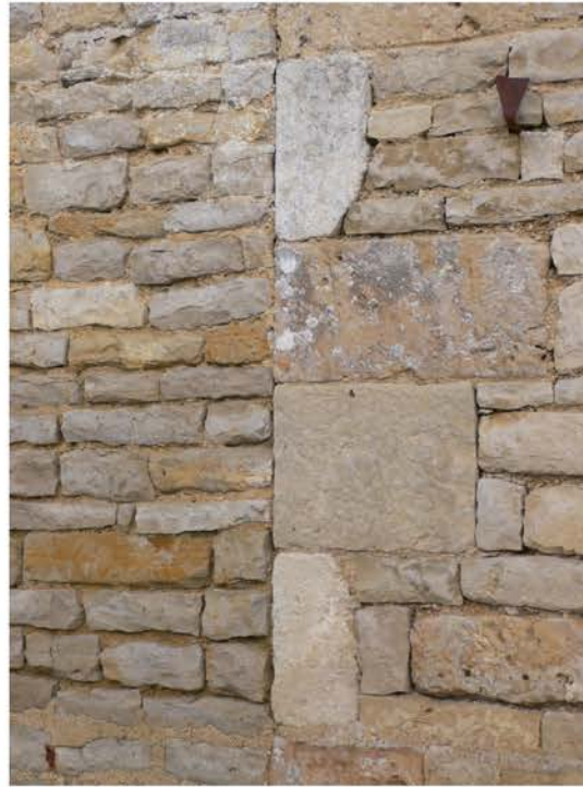
Moellons calcaires équarris, assisés et chaînage
